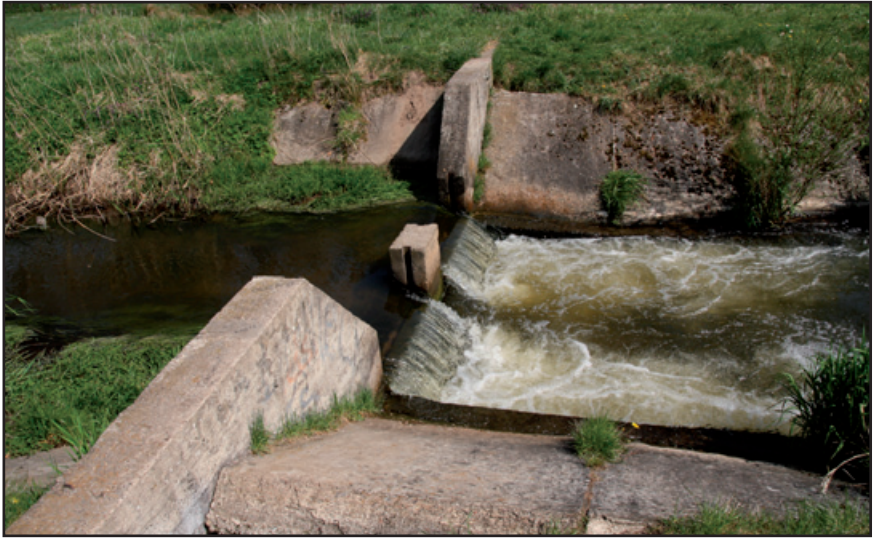
Próg betonowy w Kępie w km 1 + 589 - wysokość piętrzenia około 40 cm.
