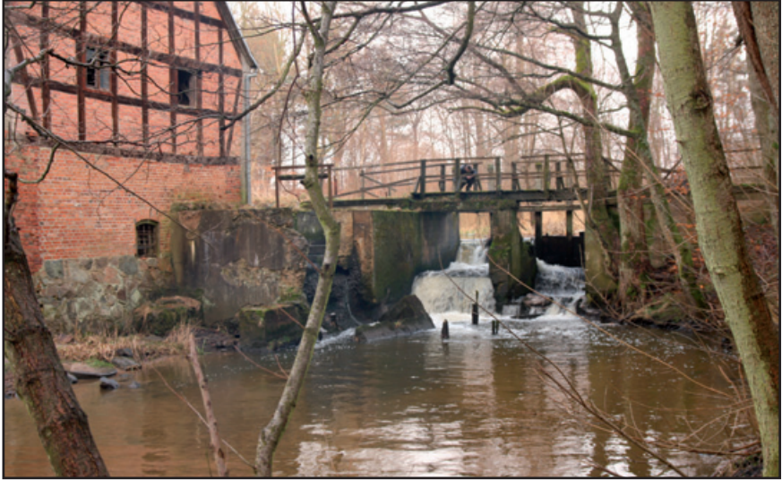
Jaz piętrzący obok starego młyna na Gnilnej w Bydlinie w km 0 + 264 - kres wędrówek ryb anadromicznych w rzece.
