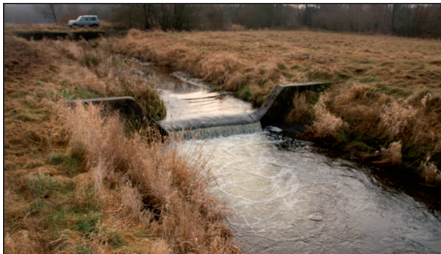
Stopień betonowy w stanowiący istotną barierę w wędrówkach małych ryb i gatunków słabiej pływających lub nie posiadających umiejętności pokonywania przeszkód skokiem - dorosłe pstragi i trocie mogą pokonać piętrzenia tej wysokości.
